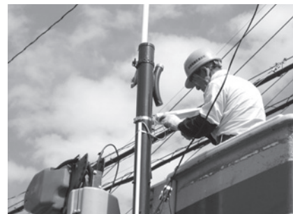
【電気工事の様子】
