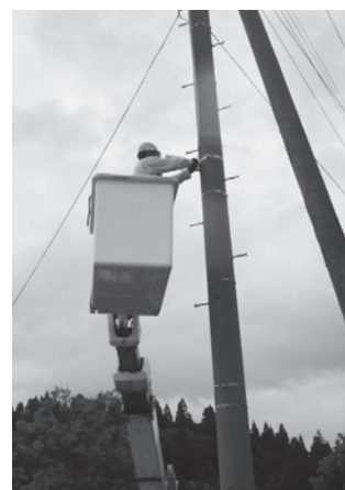
【LED切替作業の様子】
