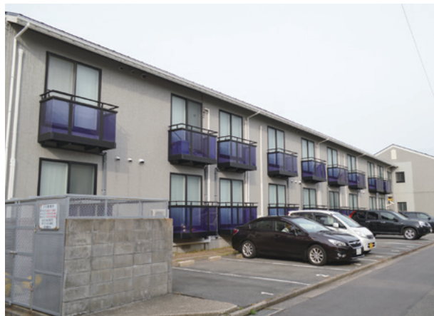
[従業員宿舎と駐車場]
