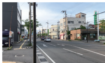
【アーケード撤去後の商店街の様子】
